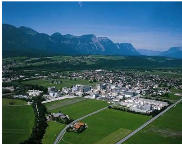
Chemiewerk Sandoz im weiten Inntalboden bei Kundl (© Sandoz GmbH)
