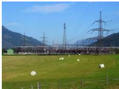
Umspannwerk in Kaprun (© Lars Keller)
