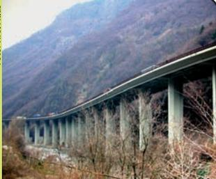
Die Südtiroler **Brennerautobahn** wurde 1974 fertig. Besonders schwierig war der Bau vom Brenner bis Bozen, wo auf 85 km Länge mehr als 30 km auf Vradukten und 6 km in Tunnels verlaufen.
